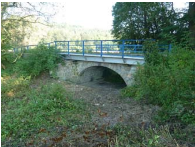
Obr. č. 63 – Košátecký potok - revitalizace
