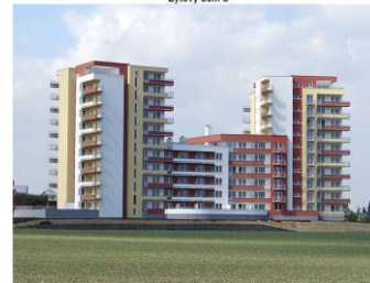
Bytový dům C
